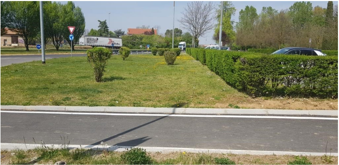
Inizio del tratto di ciclopedonale in Comune di Cavenago – intersezione stradale e e porzione di area verde a lato del parcheggio del cimitero
